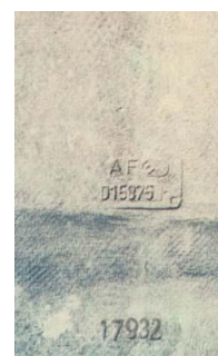
Lüftungsrohr mit Prägestempel "AF"
